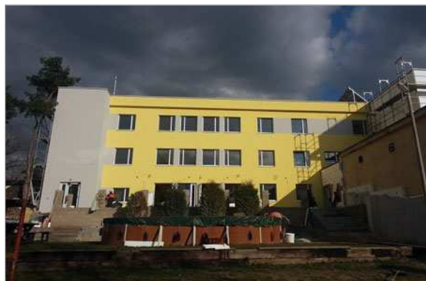
Hlavní budova areálu po rekonstrukci
