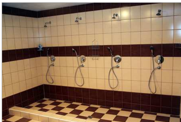
Nové sprchy na hlavní budově
